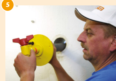
5 Die Hauptabsperreinrichtung wird im Keller installiert.
