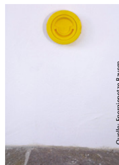
Fernauslösung: unter Putz, Vorbausäule
