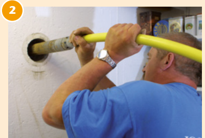
2 Die grabenlose Pressung ermöglicht die sogenannte „Rakete“.
