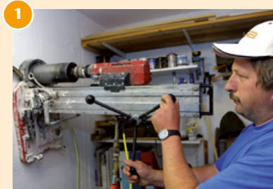
1 Mit einem Spezialgerät wird die Kernbohrung erstellt.
