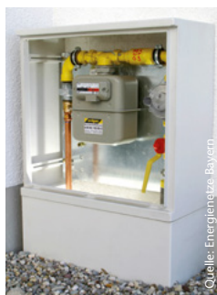
Hausanschlusskasten: geschlossen, offen
